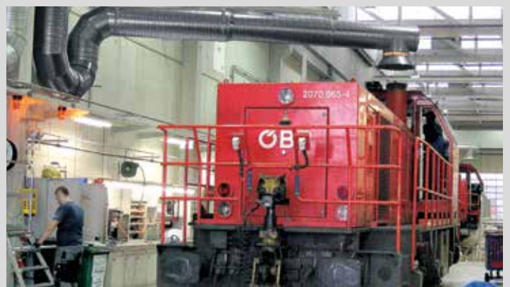
Diesellok-Absaugung mit einem schwenkbaren Auslegearm.
