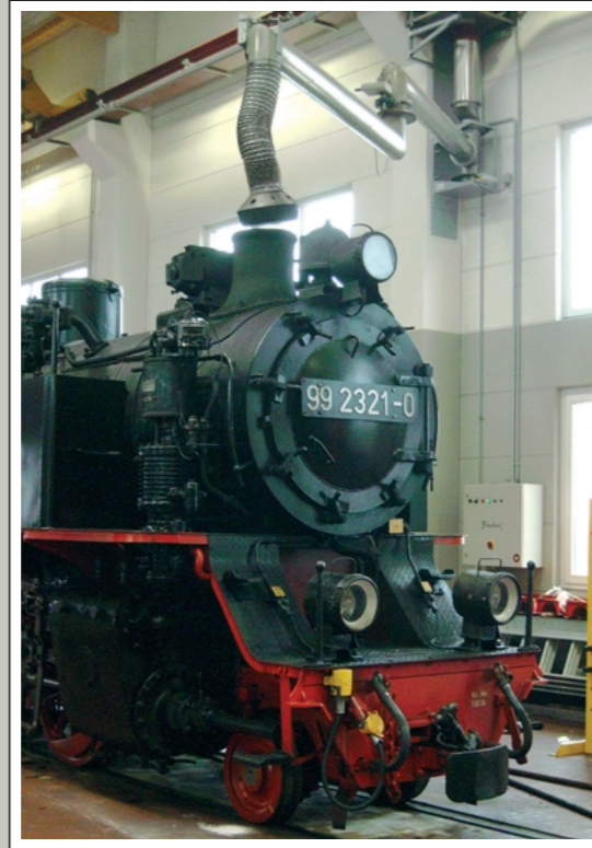
Dampflok-Absaugung bei der Mollie in Bad Doberan über einen mehrgelenkigen Absaugarm Ø 200 und Ausladung max. 5 m in Sonderausführung für die extrem schwefelsäurehaltigen Abgase.
