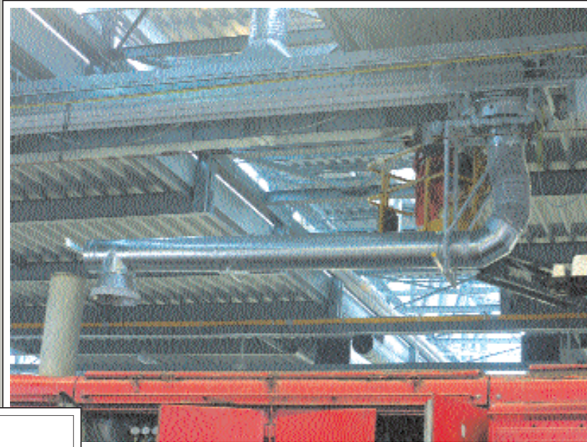
Absaugarm NW 355 in drei Ebenen verfahrbar in einer Saugschlitz-Kanalanlage Typ SSK 900 über eine Länge von 50 m mit Funkfernbedienung.
