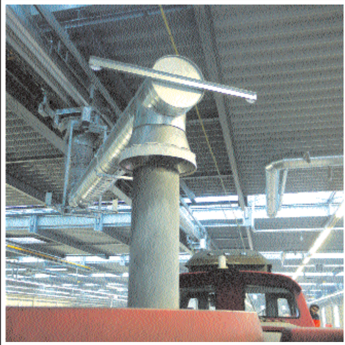
Absaughaube NW 550 höhenverstellbar mit Absaugarm NW 355 eingeschwenkt unter einem Fahrleitungsdraht bei gemischter Nutzung mit Diesel und Elektroloks.
