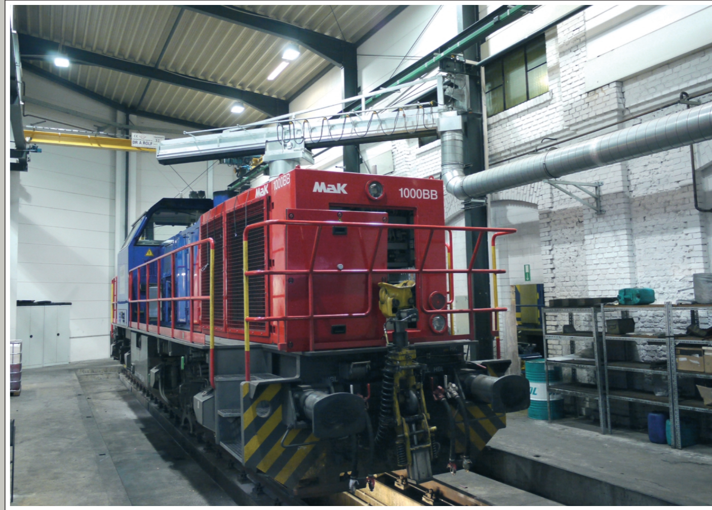
Diesellok-Absaugung in einer Service-Werkstatt der Vossloh-Werke mit einem schwenkbaren Saugschlitzkanal Typ SSK 900 für bis zu 10.000 m³/h, einstellbar in drei Achsen.
