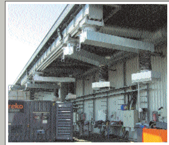
Saug Schlitzkanalanlage Typ SSK 1350 Länge 30 m mit vier Absaugwagen NW 560 für Dauerleistungstest bei dieselbetriebenen Notstromaggregaten bis 1.100 KVA Leistung, manuell verfahrbar, einschwenkbar und höhenverstellbar.
